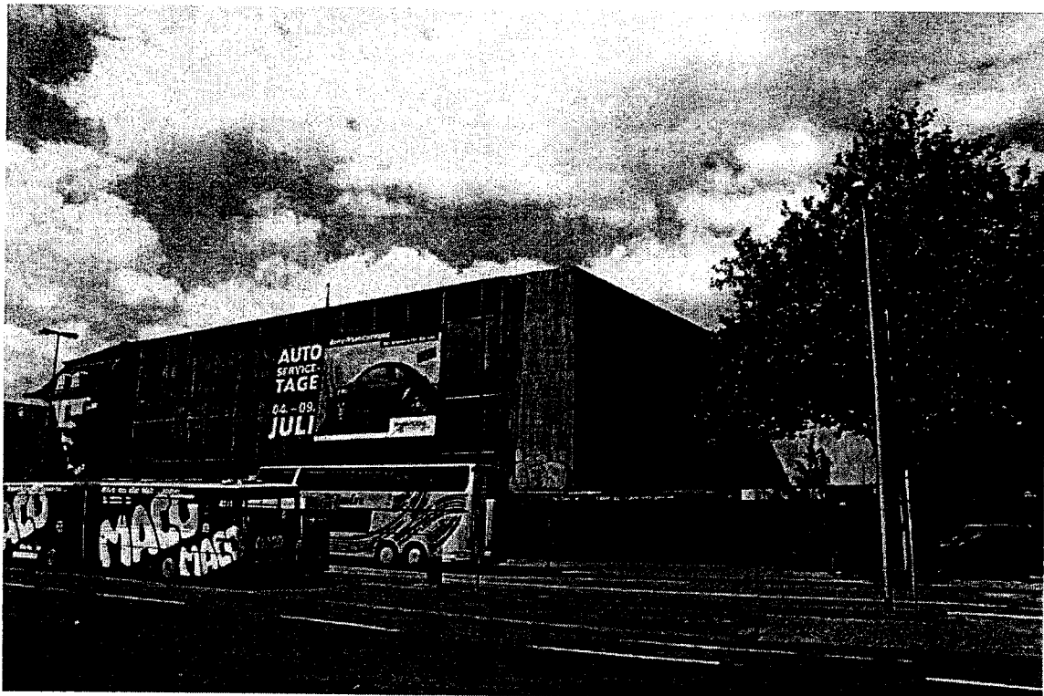
Foto 5 Ansicht Hallenbad von der Poststraße aus mit Bushaltestelle im Vordergrund
